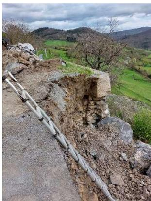
**Février 2023** : La route D978 entre Saint-Diéry et Le Cheix est temporairement fermée à cause de l'effondrement d'un mur de soutènement. Une déviation a été mise en place.
