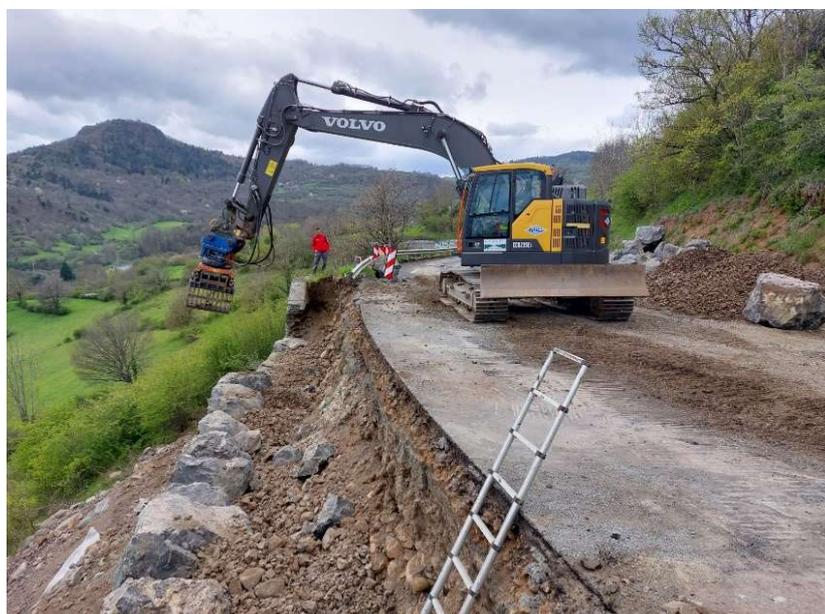
Après une étude géotechnique, le département a réalisé des travaux d'enrochement. **Le 3 mai 2023**, la route a pu être à nouveau ouverte à la circulation.
