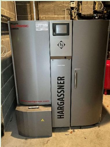
La chaudière à gaz de l'école de Cotteuges, datant de 2001, a été remplacée par une chaudière Hargassner, à granulés de bois. Equipée d'un silo de stockage de 8 tonnes, la chaudière permet de réguler automatiquement la température en fonction des besoins et suivant les jours et horaires d'ouverture de la crèche et de l'école.
